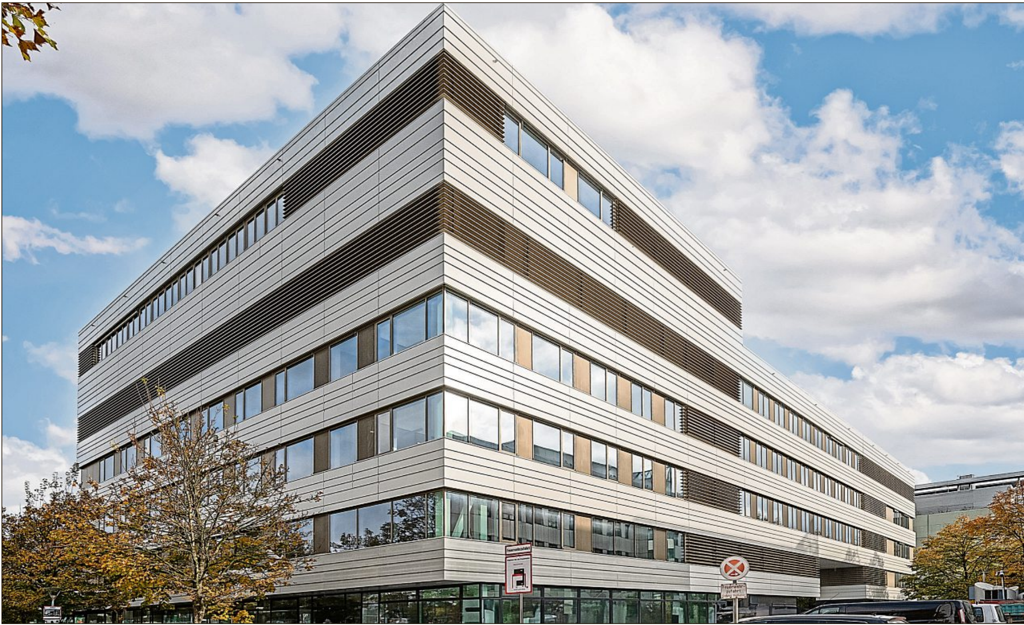
Der Forschungsneubau hat eine Bruttogeschossfläche von rund 6800 Quadratmetern.
