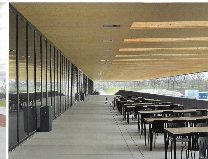
links: Das zirka 150 Meter lange und 19 Meter auskragende Holzdach aus Hohlkastenelementen rechts: Unter dem Vordach sind eine Tribüne und ein Freisitz der Cafeteria angeordnet.
