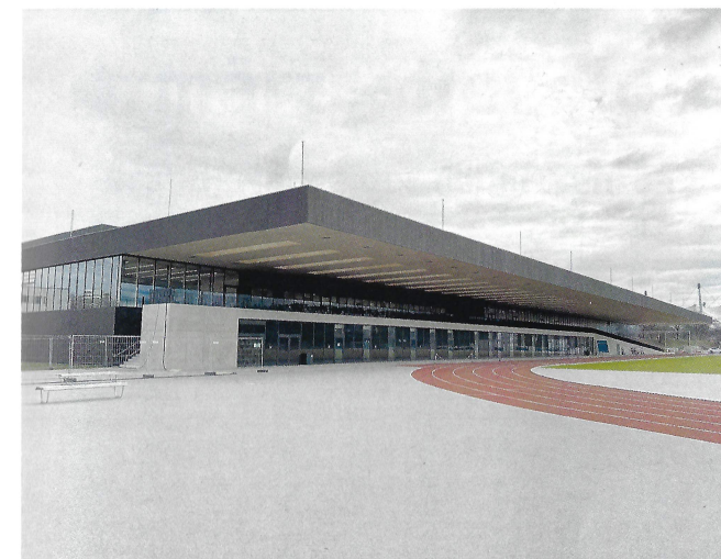
links: Das zirka 150 Meter lange und 19 Meter auskragende Holzdach aus Hohlkastenelementen rechts: Unter dem Vordach sind eine Tribüne und ein Freisitz der Cafeteria angeordnet.
