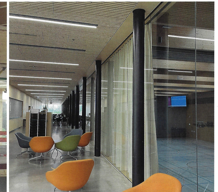
links: Die Lastabtragung der Hohlkastenelemente des Vordaches erfolgt auf Stahlstützen. rechts: Dieselben Stahlstützen sind mit Holz gekapselt.
