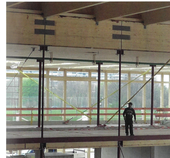
links: Die Lastabtragung der Hohlkastenelemente des Vordaches erfolgt auf Stahlstützen. rechts: Dieselben Stahlstützen sind mit Holz gekapselt.
