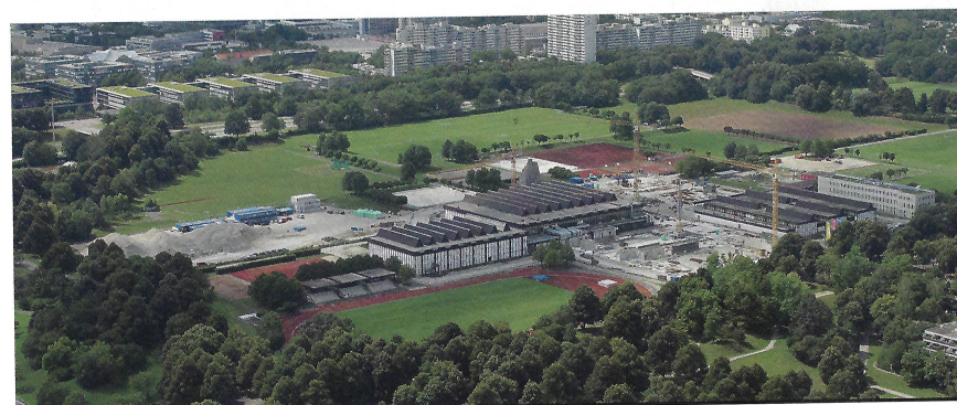
Luftbild der Baustelle im Juli 2018
